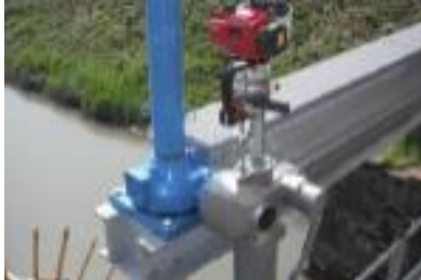
Kit Emergencial no Atuador Elétrico AUMA
