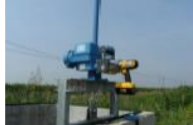
Kit Emergencial no Atuador Elétrico DREHMO
