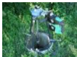
APB60N na válvula subterrânea
